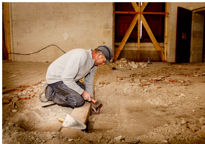
Sondages des charpentes et des planchers de l'aile François I er © Léonard de Serres
