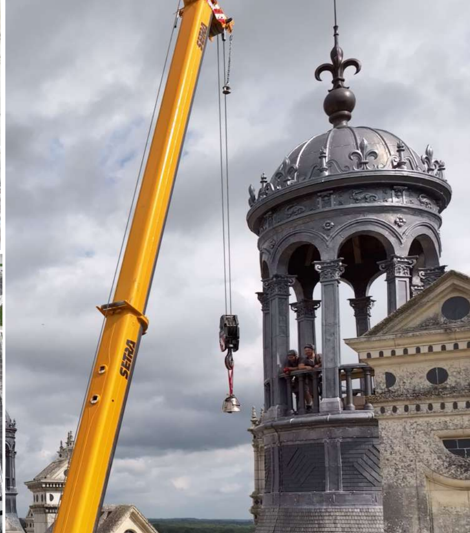
Installation des cloches - mardi 19 septembre 2023 © Olivier Marchant - Domaine national de Chambord
