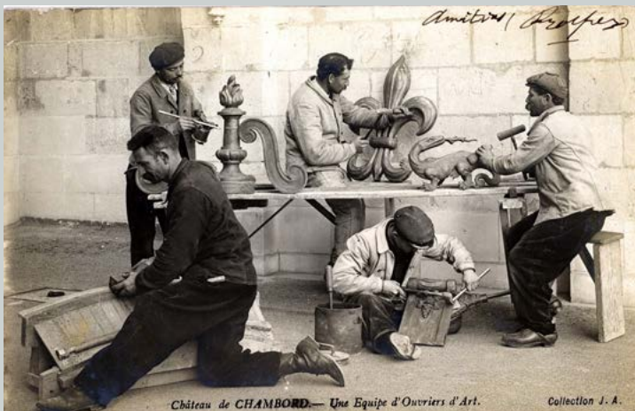
Ouvriers de l'atelier Monduit Fils photographiés sur les terrasses du château fin XIX e (carte postale des collections de Chambord)
